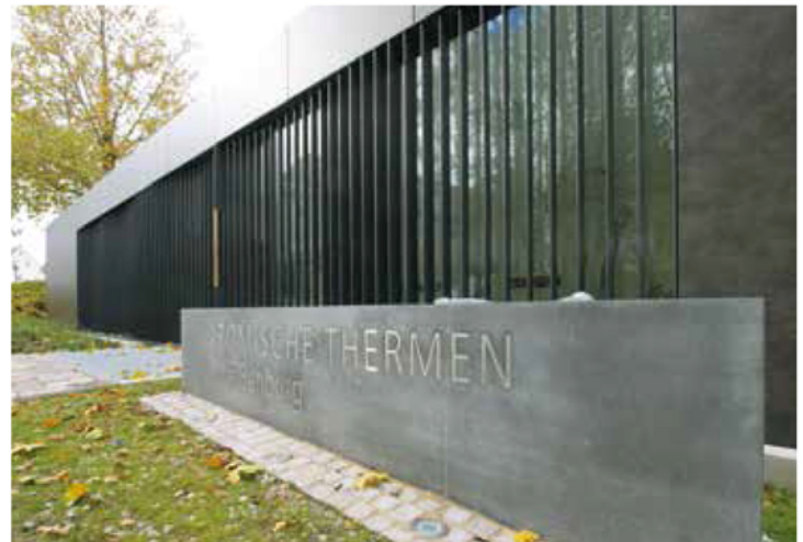
Eingangsfrent des neuen Empfangsgebäudes an den Römischen Thermen Weißenburg, löhle neubauer architekten bda, Augsburg.
